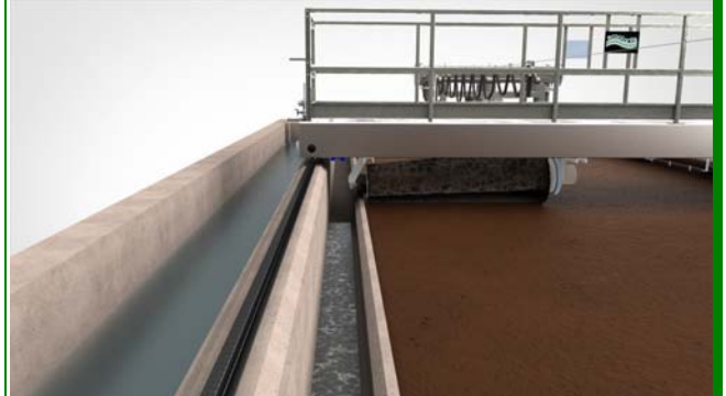
Rimozione meccanica del fango Mechanically sludge removal
